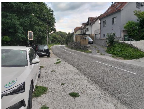
Slika 10: Nevaren odsek Teharska Pločniki se končajo.
